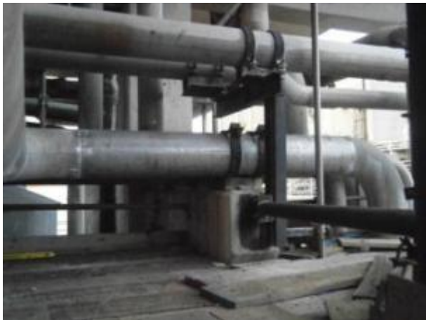
OM-22530699 SUBSTITUIR 6M TUBO DE 12" SCH10 A/I TAG 125BB304
